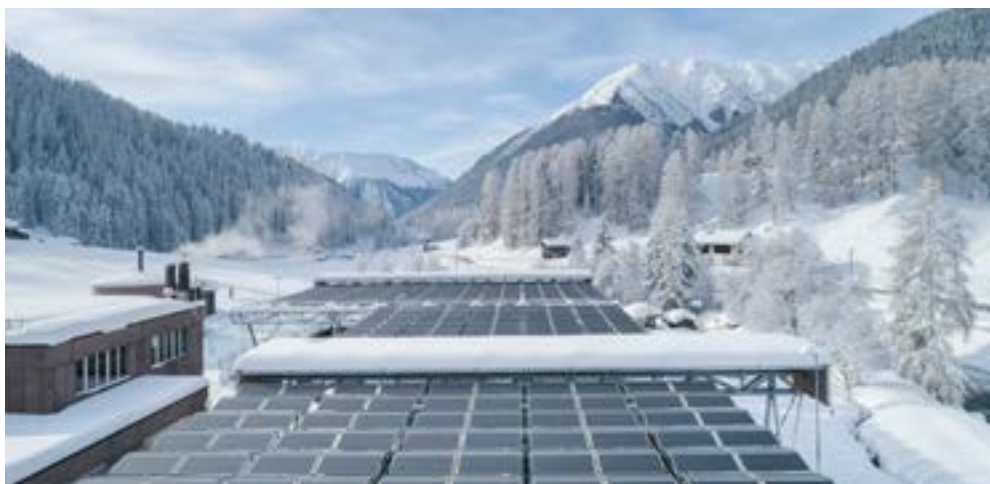
Das erste hochalpine Solarfaltdach entstand über der Kläranlage Davos.
