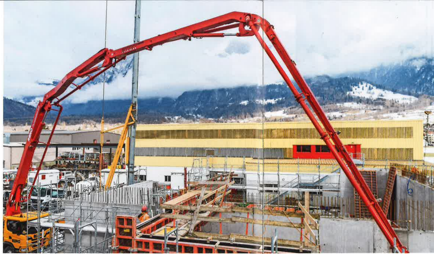
Verarbeitung von CO 2 -Beton bei Zindel United im Januar 2022.
